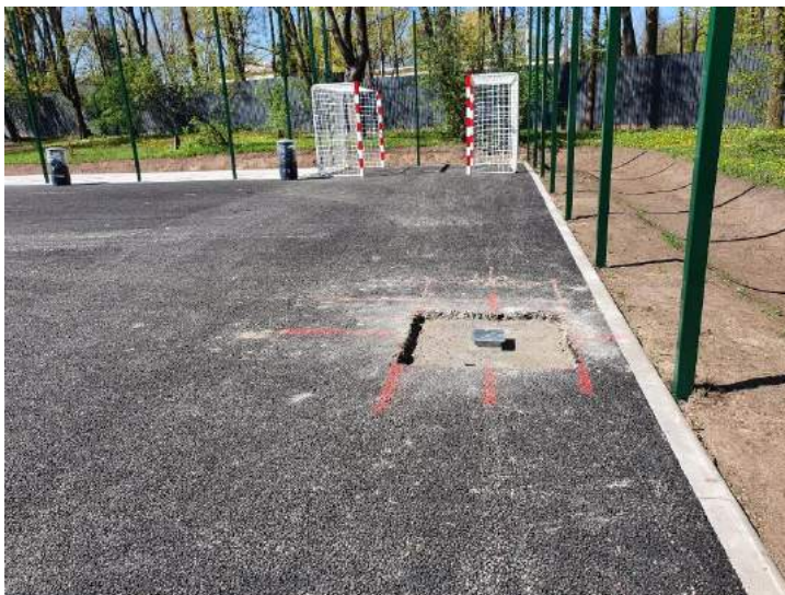
basketbola groza stiprināšanas vieta segumā un skats uz handbola vārtu atrašanās vietu laukumā, kad tie netiek izmantoti
