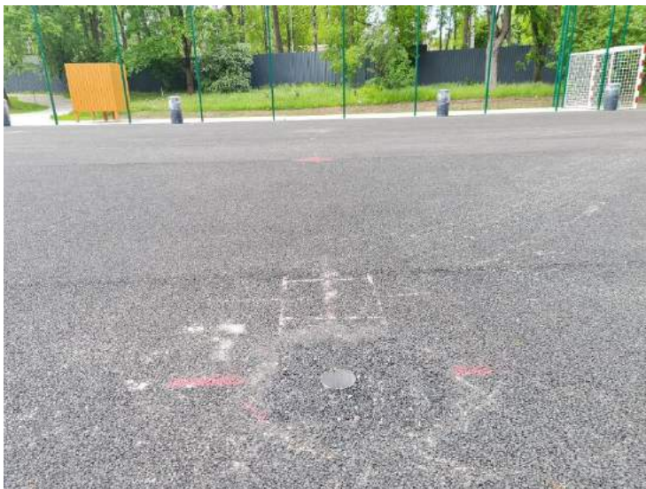
volejbola stabu stiprināšanas vietas segumā
