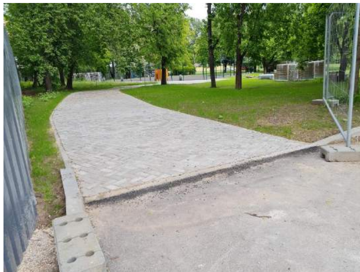
Skats uz celiņu no Straumes ielas (savieno laukumu un Straumes ielu) – esošais bortakmens tika pazemināts, lai veidotu vienotu savienojumu celiņam un Straumes ielai
